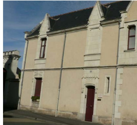
L'enduit laisse apparaître les éléments de décor en pierre
