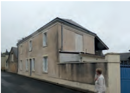
>>> Maison Tijou avant travaux
